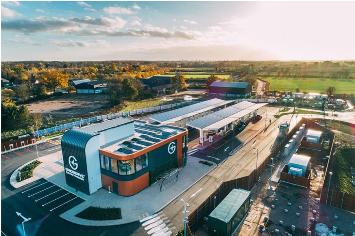
Figura 42 Estación de carga masiva de Essex
